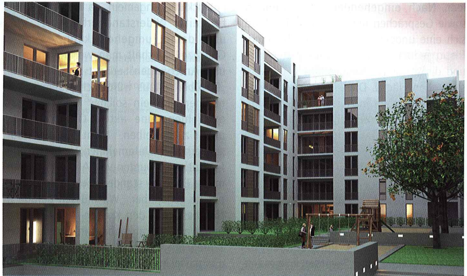
Johns Home heißt dieses Neubauprojekt von BBT und Berliner Volksbank in Berlin-Prenzlauer Berg, in dem dank strikter Kostenkontrolle relativ günstige Eigentumswohnungen entstehen.
