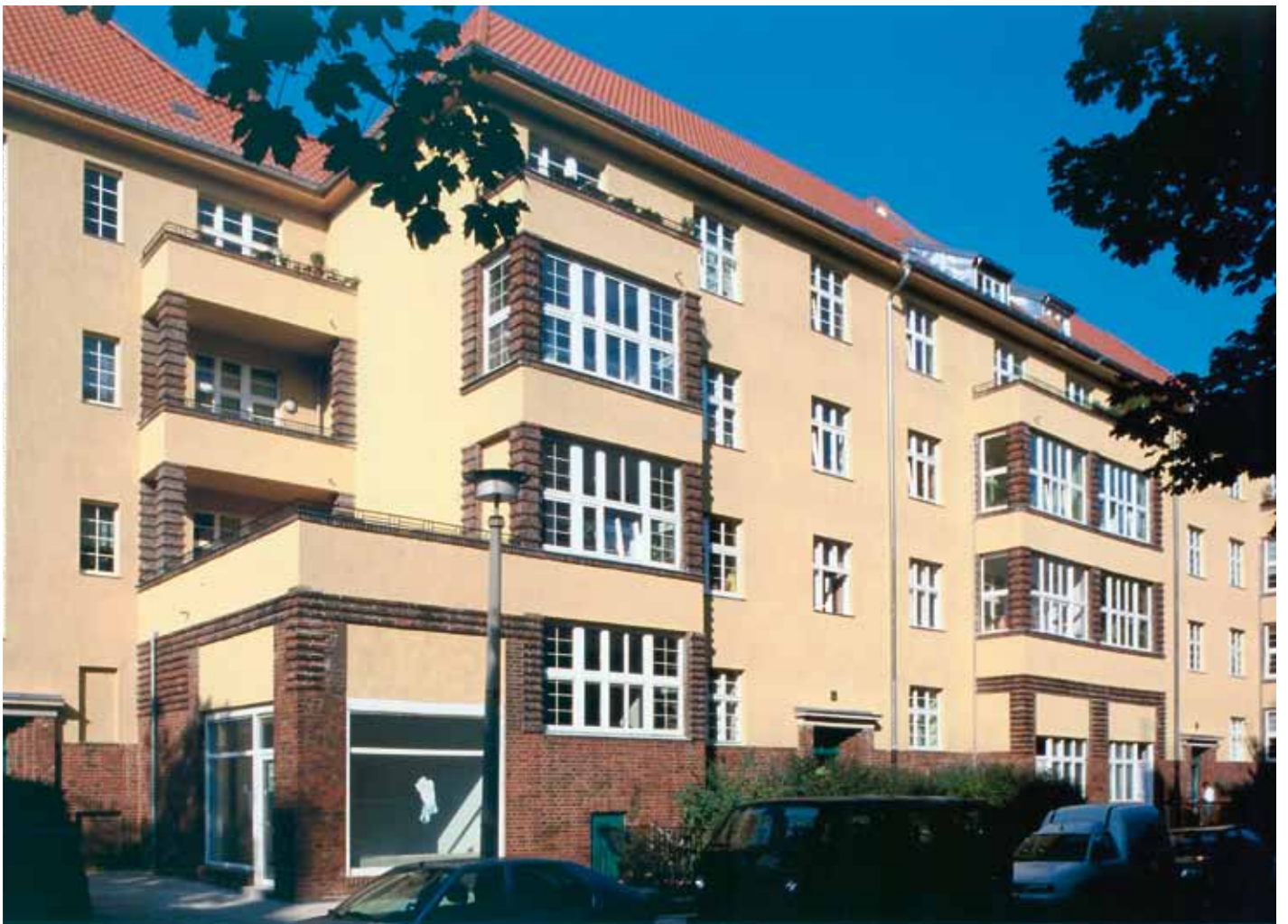
Projekt Modernisierung und Instandsetzung Meyerbeerstraße in Berlin – GESOBAU AG, Berlin
